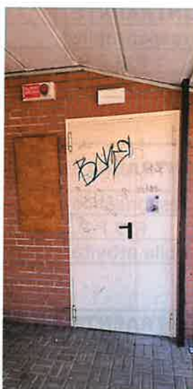
Accesso porta di sicurezza
